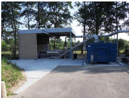
AFBEELDING 1 FIJNZEEFINSTALLATIE RWZI BLARICUM)
